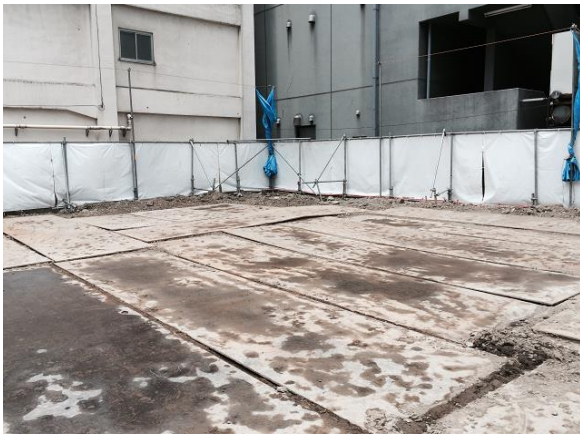
(平成31年2月20日現在 進交会館建設現場)
